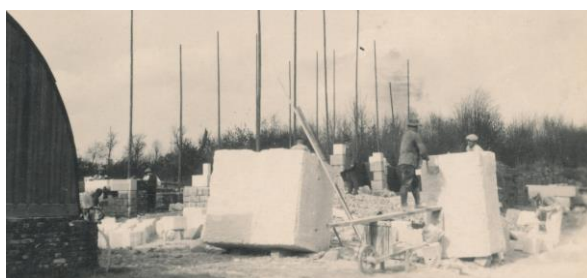
I lavoratori nel cantiere di Herbecourt preparano le pietre per le costruzioni. Ecco una lista dei lavori più importanti eseguiti.
